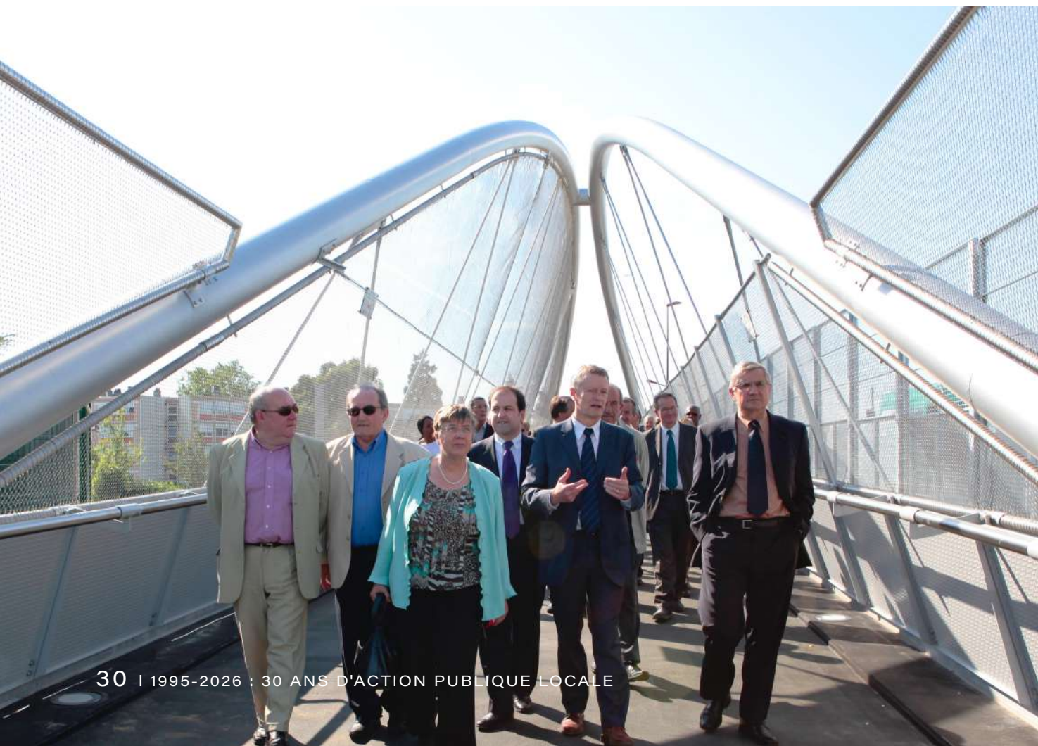
L'inauguration de la passerelle du pont d'Écouen réalisé le 29 juin 2009
