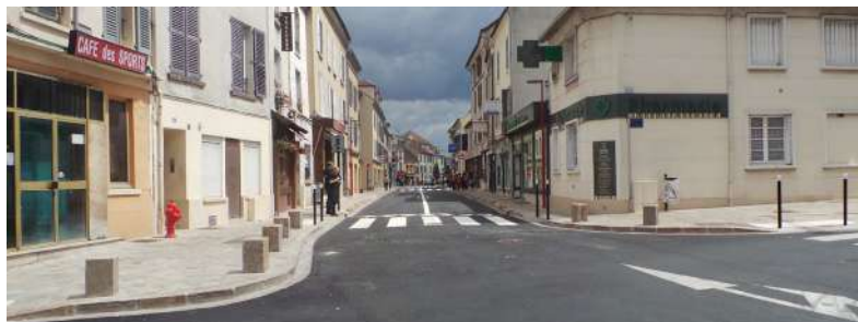
La rue de Paris rénovée en 2013
