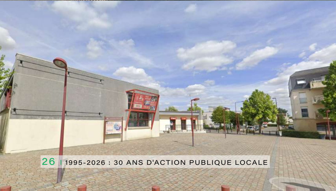
La Maison des Habitants Louis Aragon construite après la démolition du « blockhaus », ici en 2012
