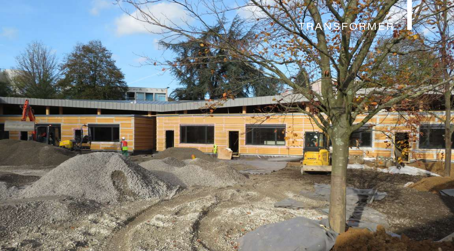
La construction de l'école Marc Bloch en novembre 2020
