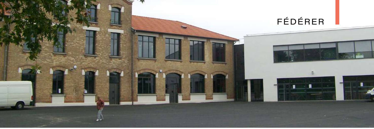
L'école Roger Salengro en 2013 après travaux
