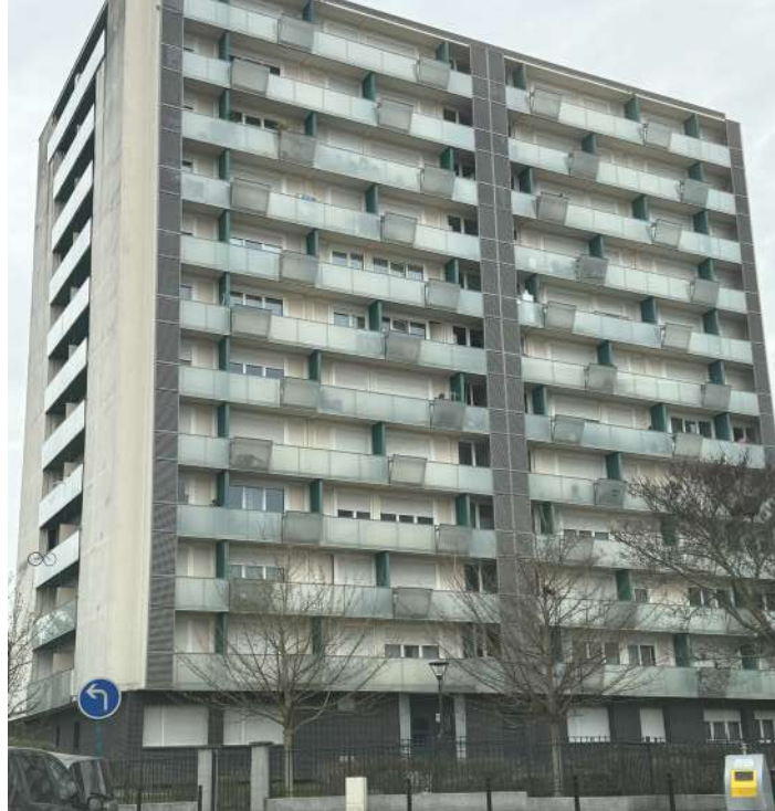
Immeuble réhabilité à la Fauconnière
