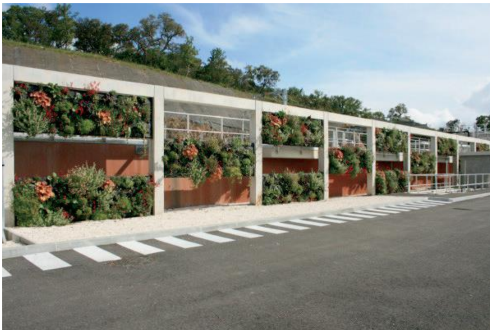
Figure 9 exemple de mur végétal acoustique, le produit a été testé en laboratoire et classé A 4 en tant qu'écran acoustique (document jungle art / http://murvegetal.com/acoustique/ ).
