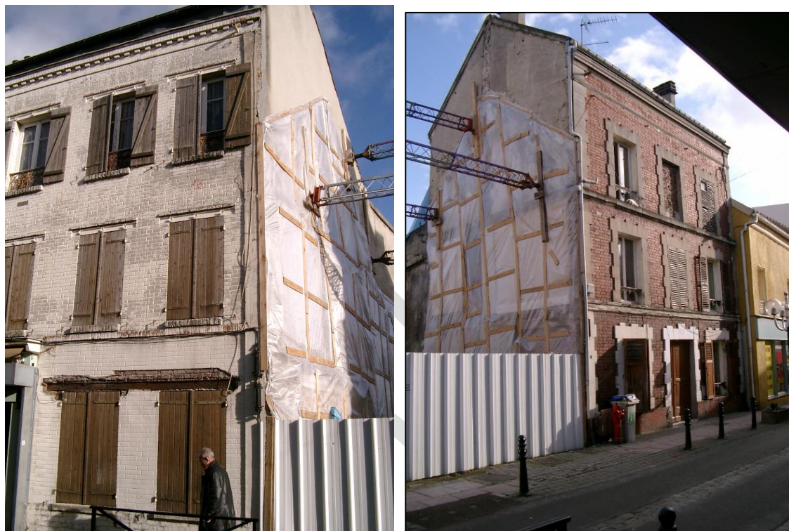
FIGURE 4 A GAUCHE 16-18 RUE GENERAL LECLERC, A DROITE 12 RUE GENERAL LECLERC AVANT LEUR DEMOLITION (2012)
