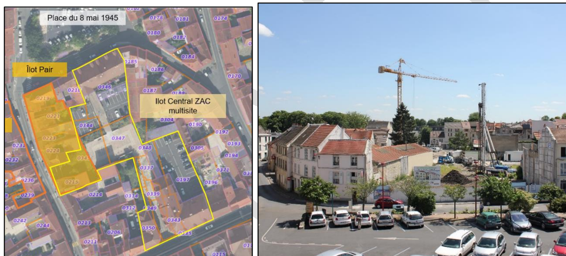
FIGURE 3 PERIMETRE ZAC ET PERIMETRE DE L'ÎLOT, A DROITE TRAVAUX DE LA PREMIERE OPERATION (2012)
