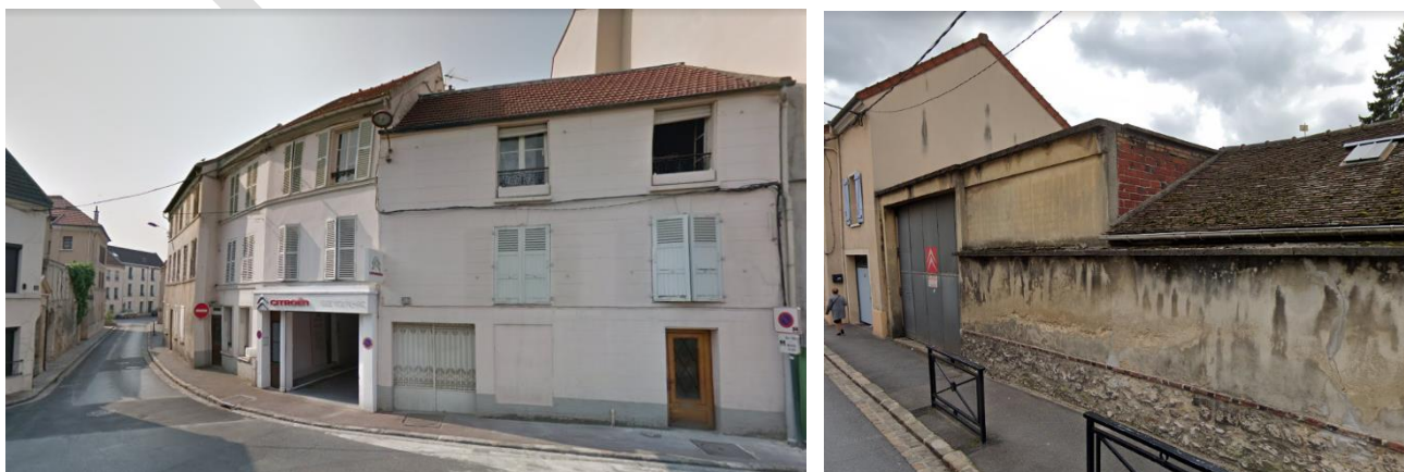
FIGURE 17 VUES DU SITES DEPUIS LA RUE
