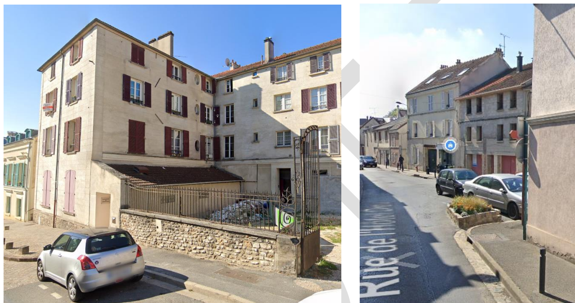
FIGURE 18 DEUX ENSEMBLES IMMOBILIERS ANCIENS, RUE GENERAL LECLERC ET RUE DE L'HOTEL DIEU
