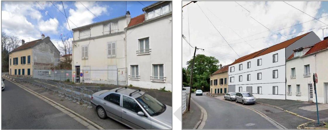
FIGURE 2 PHOTOGRAPHIE AVANT DEMOLITION DU BATIMENT B ET EXTRAIT DE L'ETUDE DE CAPACITE ANNEXEE A LA DUP
