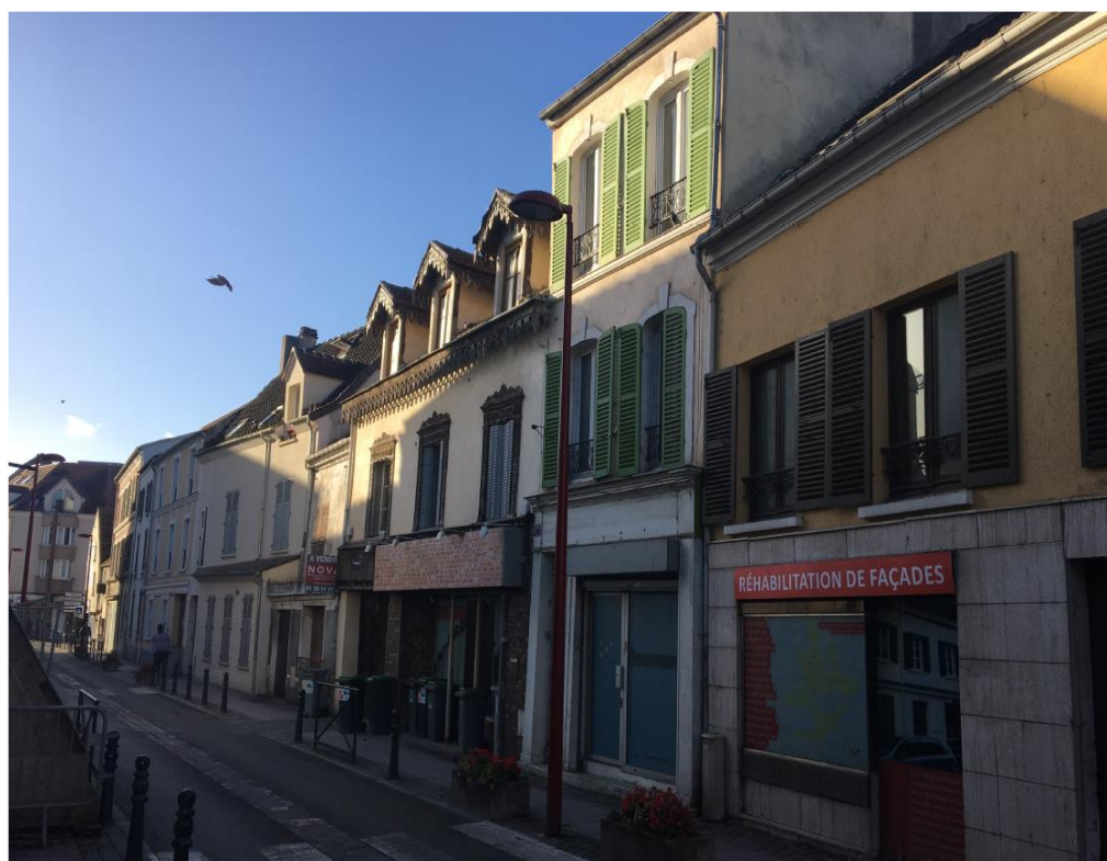
FIGURE 6 VUE SUR LA RUE GENERAL LECLERC COTE IMPAIR
