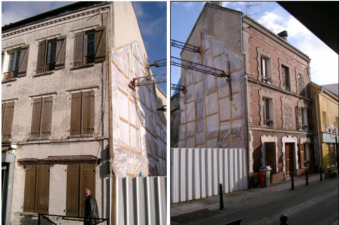
Figure 32 A gauche 16-18 rue général Leclerc, a droite 12 rue général Leclerc avant leur démolition (2012) (Source : Dossier de modification n°3 du PLU)
