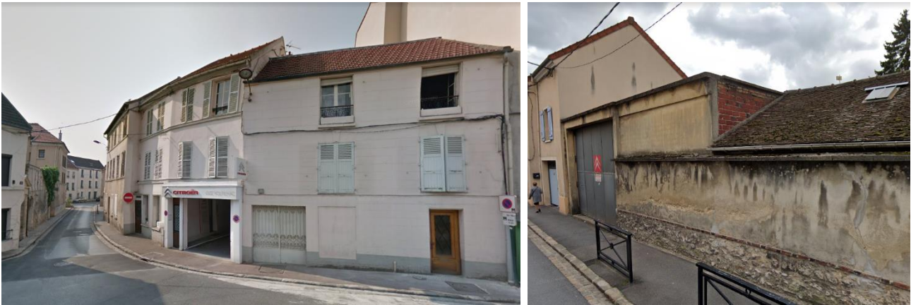
Figure 49 Vues du site depuis la rue (Source : Dossier de modification n°3 du PLU)
