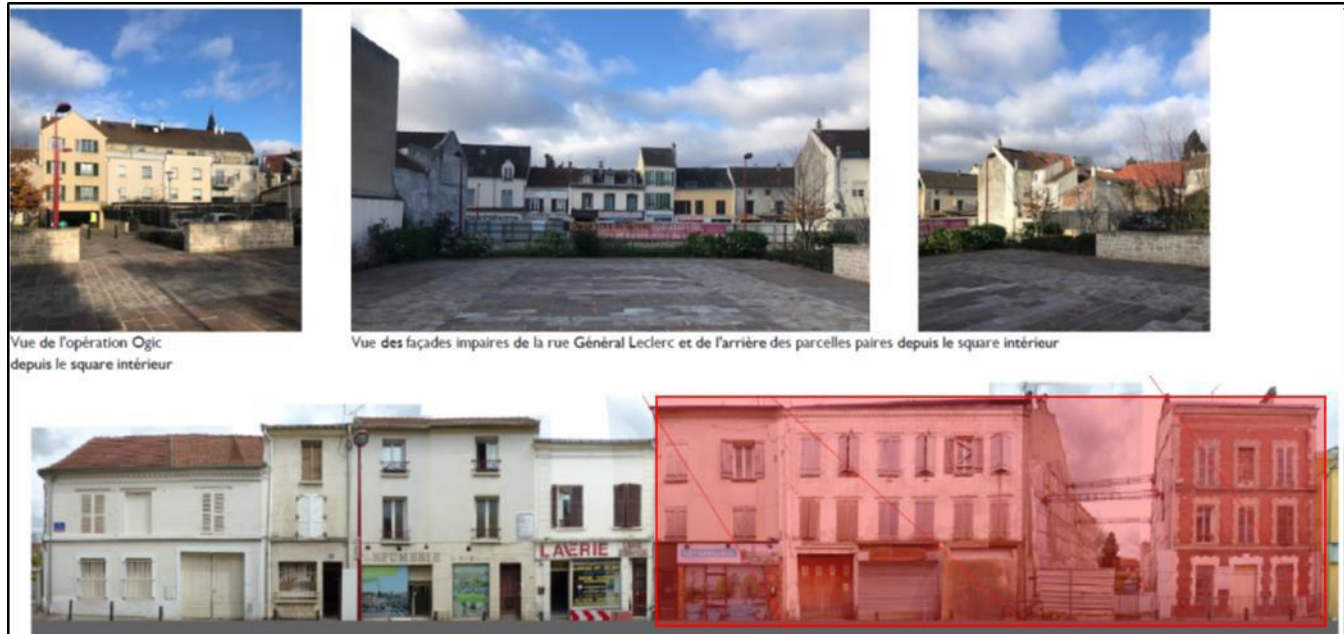
Figure 33 Ilot Leclerc pair, reportage photographique avant/ après démolition (Source : Dossier de modification n°3 du PLU)
