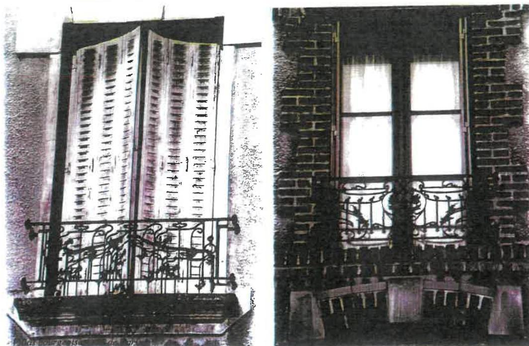
Garde-corps implantés sur la façade pour permettre aux volets métalliques de se replier sur le tableau des baies.
