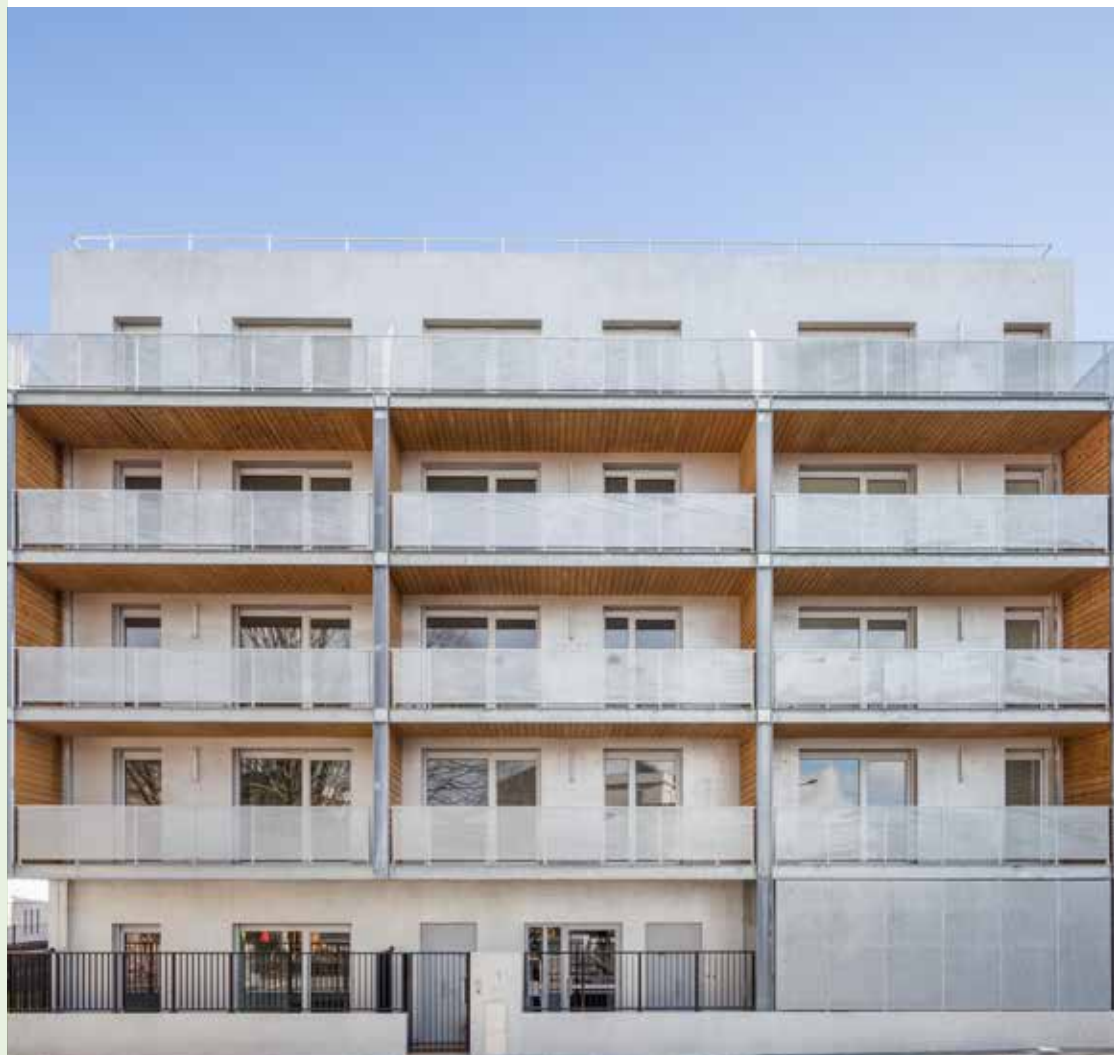
Nouvelle construction Rue Chauvart
