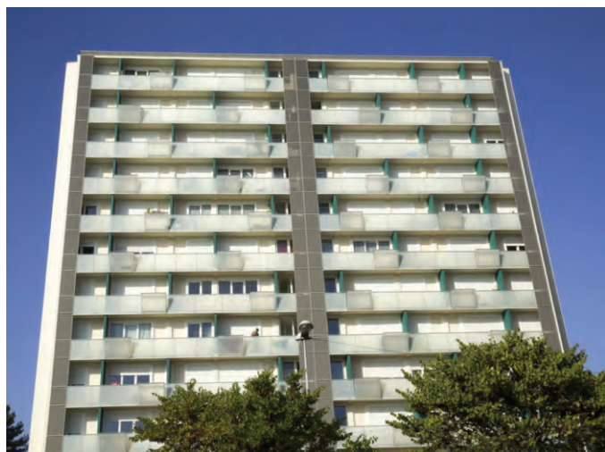
Une résidence de 534 logements, dans le quartier de la Fauconnière, a fait l'objet d'une grande réhabilitation.
