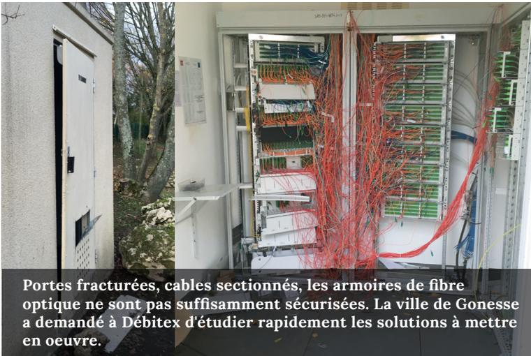
Portes fracturées, câbles sectionnés, les armoires de fibre optique ne sont pas suffisamment sécurisées. La ville de Gonesse a demandé à Débitex d'étudier rapidement les solutions à mettre en oeuvre.
