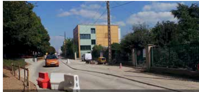
Rue Claret : un parvis devant l'entrée de l'école Malvitte a été créé cet été afin de sécuriser l'accès pour les enfants. De ce fait, le tracé de la rue a également été modifié pour ralentir la vitesse des automobilistes.
