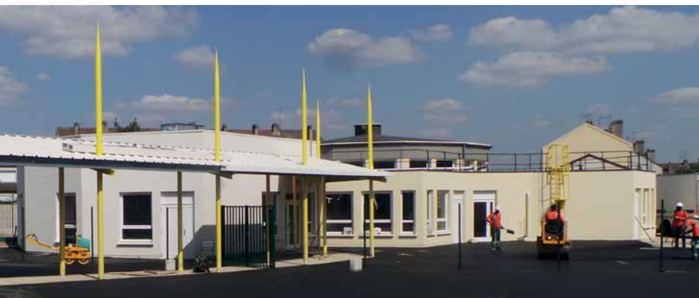
L'école Peguy Perrault a été transformée cet été. Les élèves bénéficieront d'un nouveau préau et d'un nouveau passage abrité reliant les bâtiments ainsi que d'une cour entièrement rénovée.
