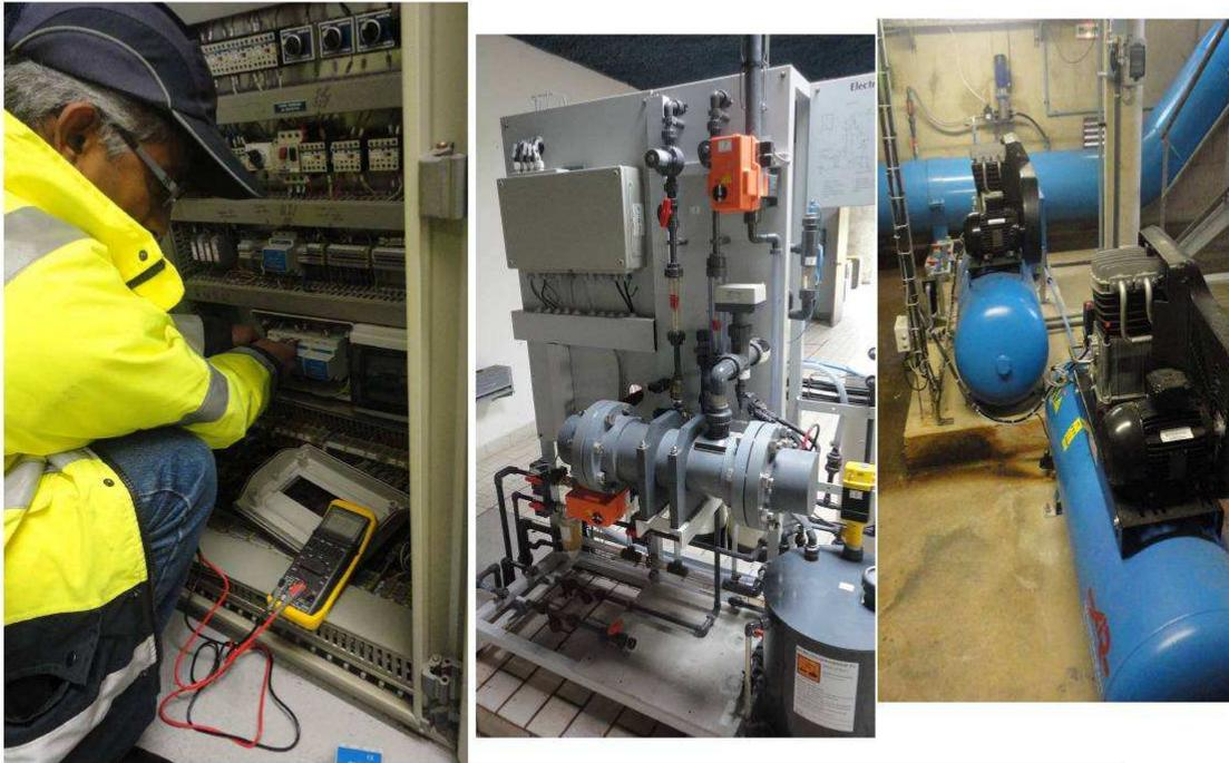
Opération de mesure de tension. Maintenance sur électrolyseur et compresseur. Installation d'une télégestion SOFREL dans une armoire. Contrôle de paramètre sur la supervision
