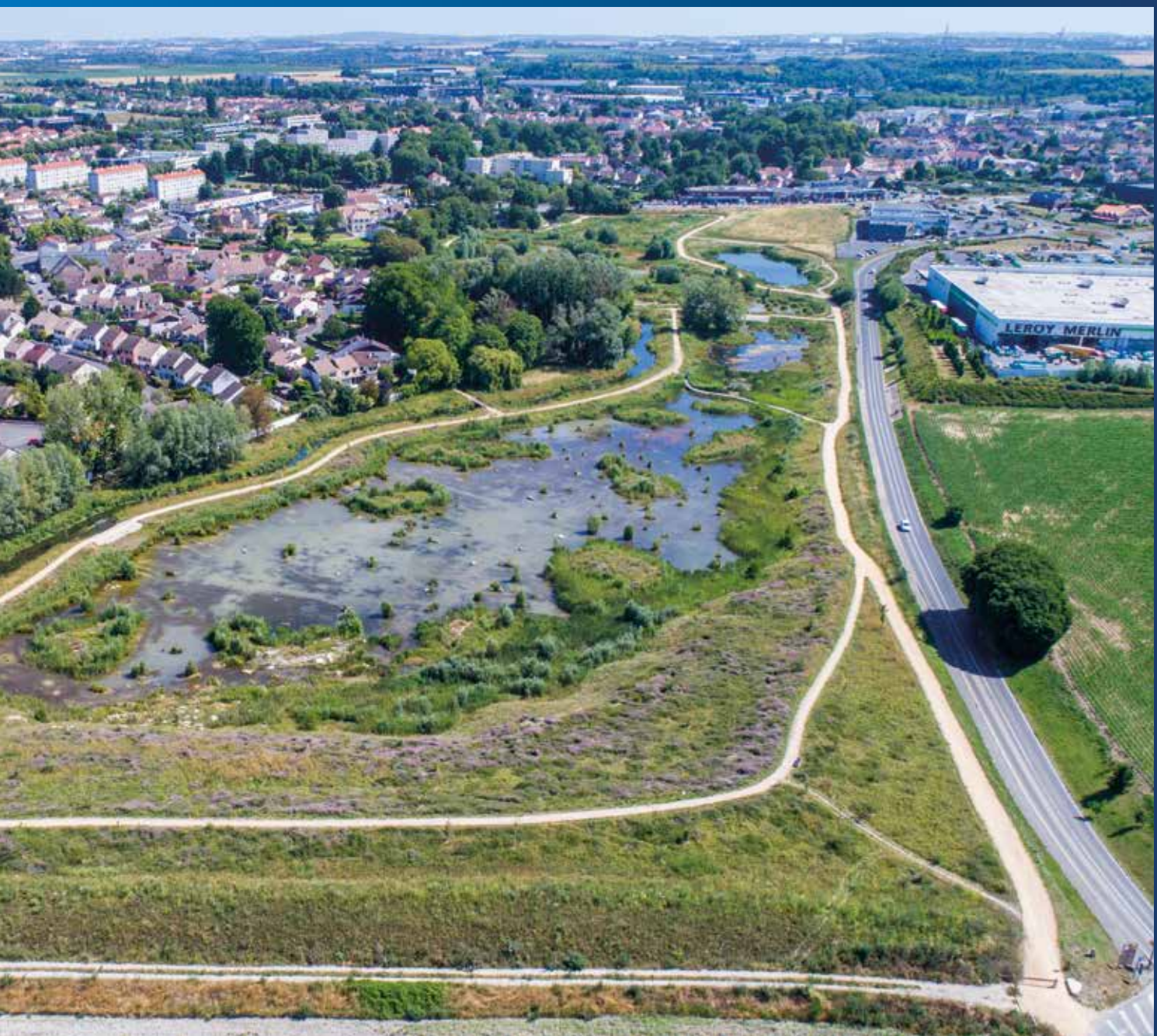
Zone d'expansion de crue du Vignois
