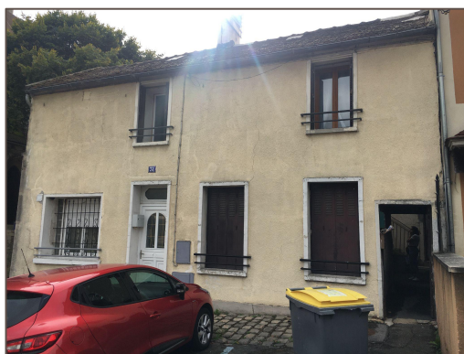
Photo du pignon du n°33 : présence d'un "ventre" sur la façade
