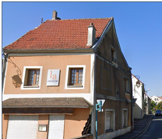
Photo du pignon du n°33 : présence d'un "ventre" sur la façade
