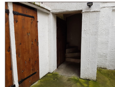
Vue du sol de la cour (photo 2018)
