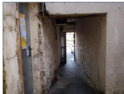
Photos gauche et droite : accès à la cour intérieure et aux logements du n°33 qui s'effectue via un porche étroit creusé dans le n°31
