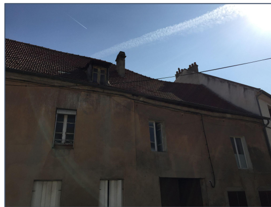
Ci-dessus, vue de la toiture en très mauvais état et déformé
