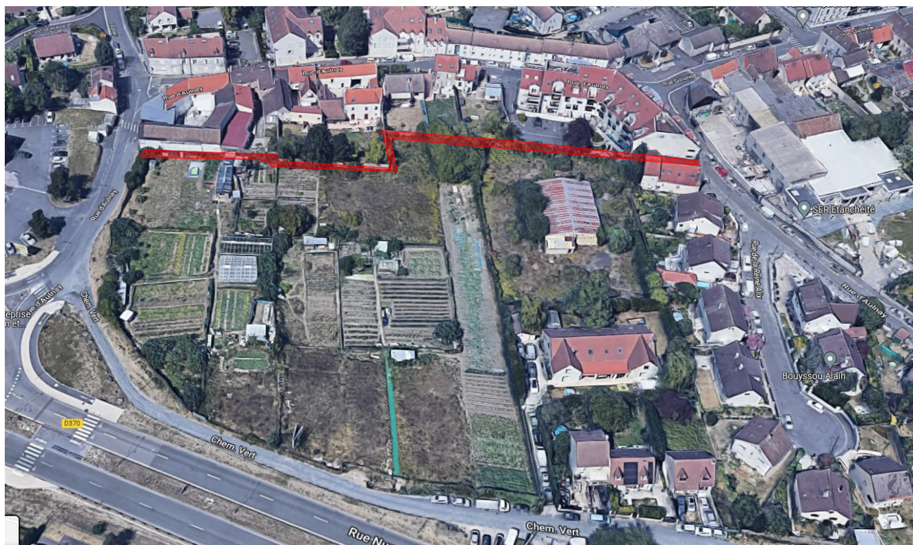
FIGURE 1 VUE AERIENNE FIGURANT L'EMPRISE OBJET DE L'ALIENATION
