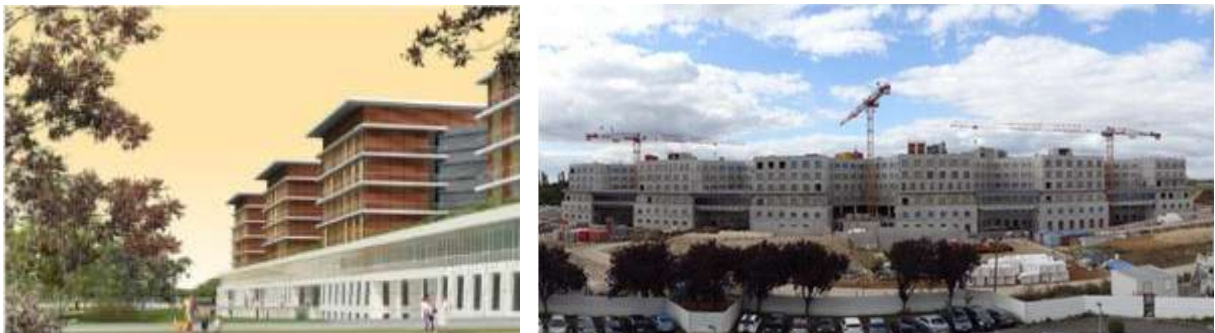
Figure 24 - Projet et réalisation de l'hôpital de Gonesse
