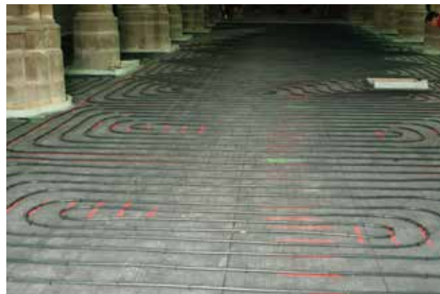
Phase de travaux du chauffage. Mise en place des serpentins d'eau chaude.
