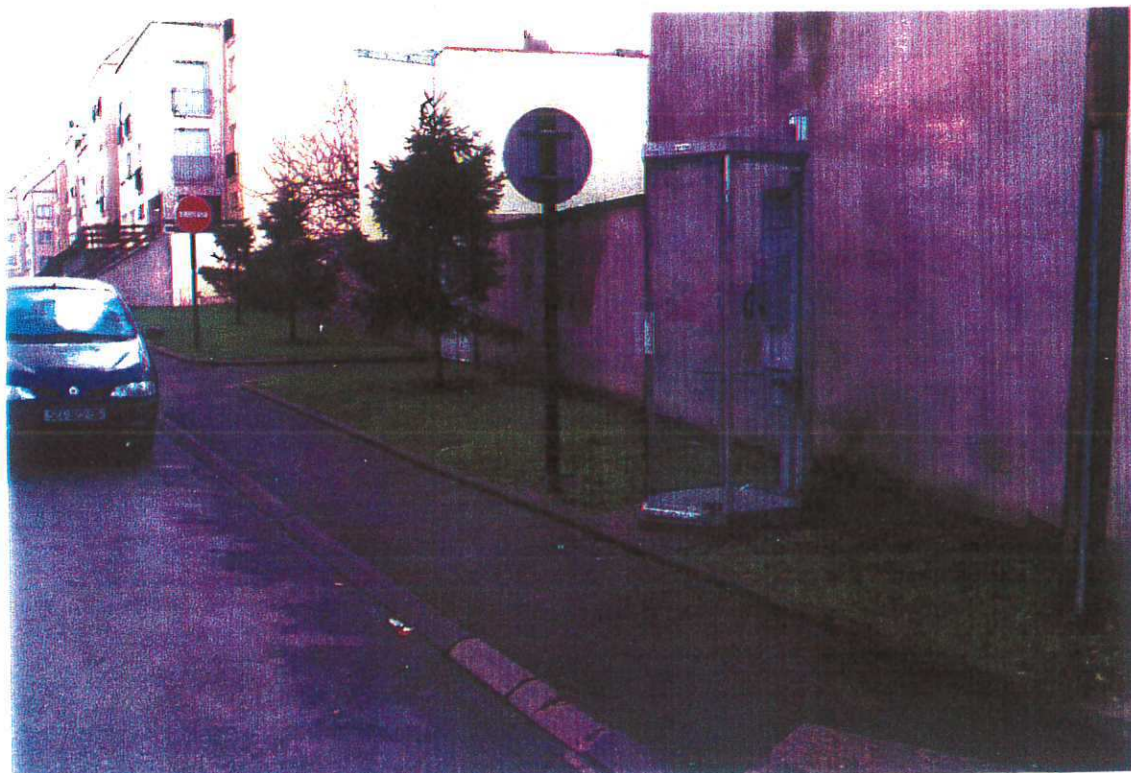
- Rue Henri Dunant - bordures en béton.
