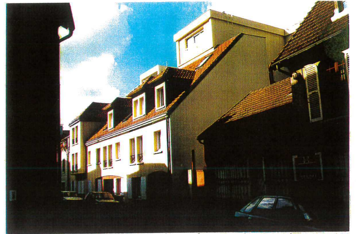
- n°31 rue Galande - bow-windows et excroissance en toiture contrastant avec l'architecture du centre de Gonesse.
