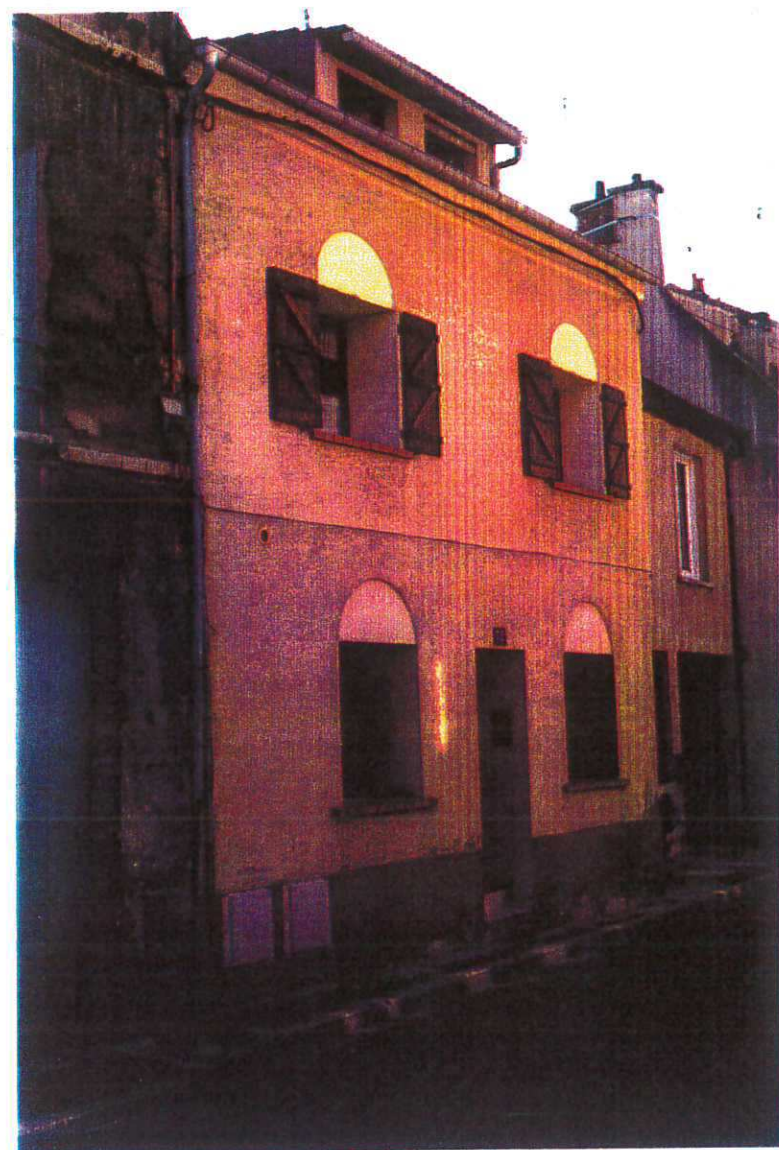
- n°52 rue Galande - transformation des ouvertures.
