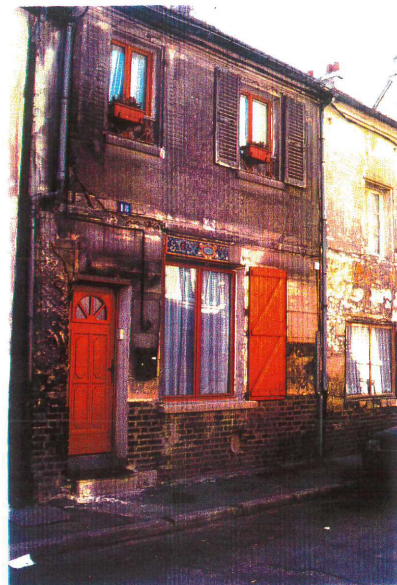
- n°18 rue Galande - transformation des ouvertures.
