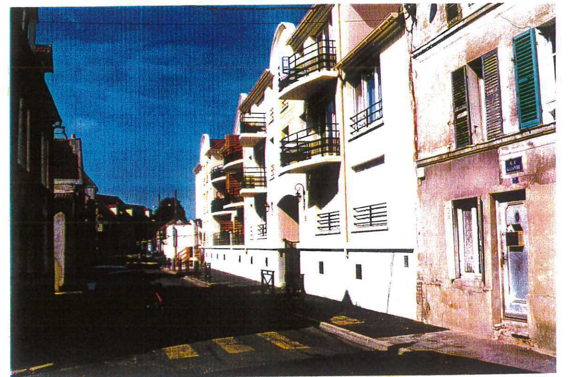
- n°3/5 rue Galande - balcons contrastant avec les façades plates du centre ville.
