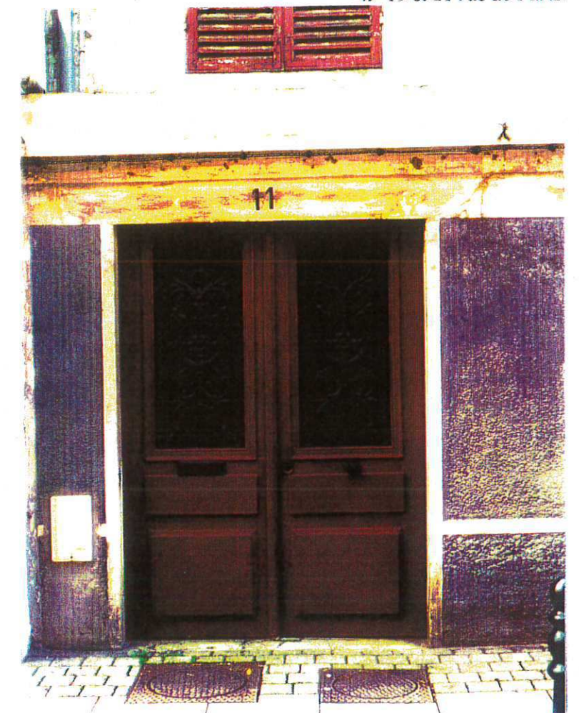
- n°11 rue du Général Leclerc.
