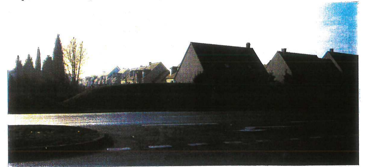
- Vue 3, depuis le boulevard de l'Hôpital.
