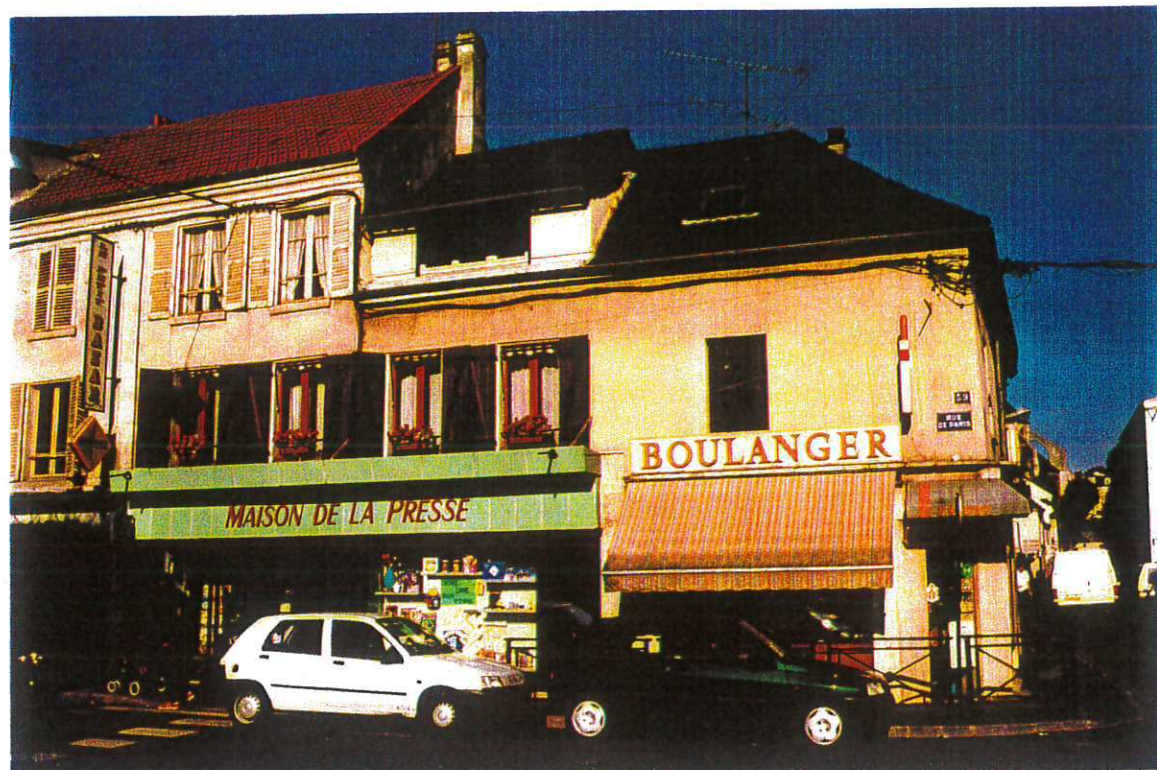
- n°59 rue de Paris - devantures ne tenant pas compte de l'architecture de l'immeuble - auvent, couleur, absence de lecture du découpage parcellaire.
