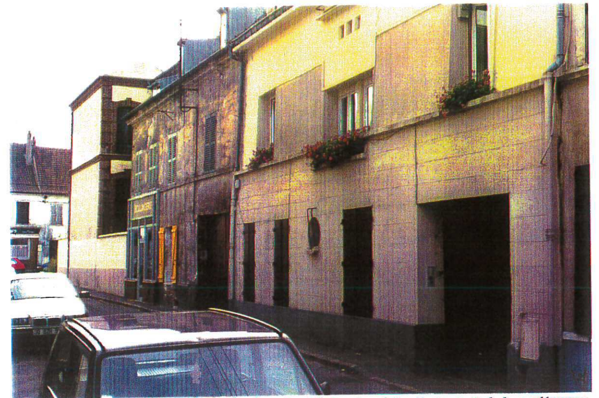
- n°18 rue Saint-Nicolas - transformation des ouvertures et de la modénature.
