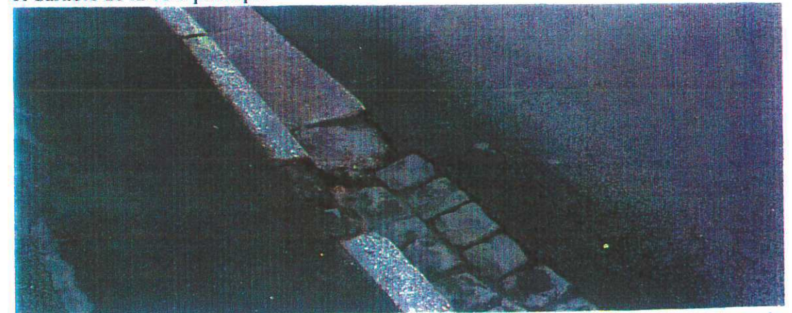
- Rue Emmanuel Rain - bordures en béton et caniveaux béton et pavés.
