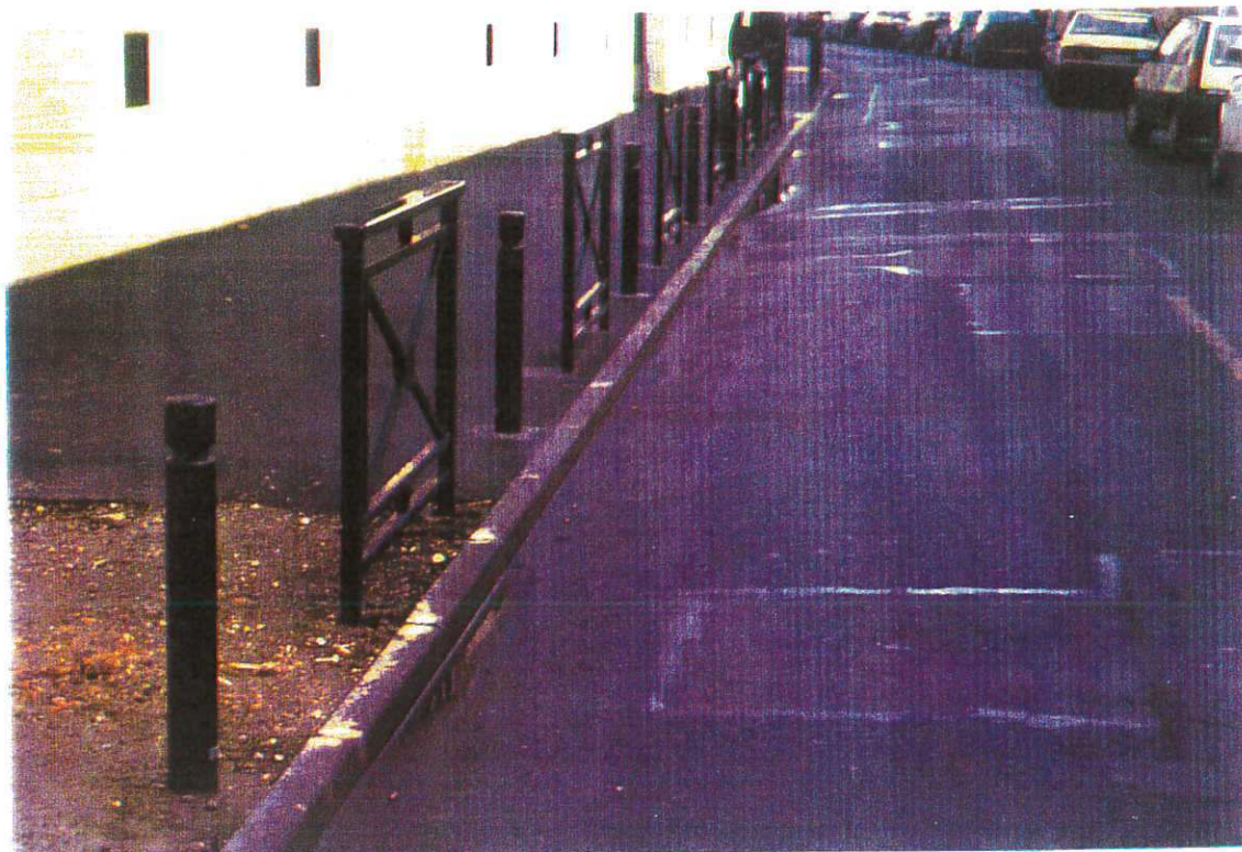
- Rue Galande - bordures en béton.
