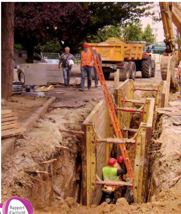
→ Pose de 310 ml de canalisation en grès de diamètre 300 mm entre 4 et 5 m de profondeur,
